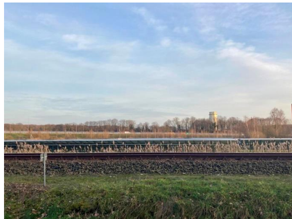
Zonnepark gezien vanaf woonwijk
