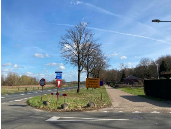
Belfeld: Richting Belfeld-dorp/Tegelen` Mededeling: afgesloten, maar geen instructie en geen maatregelen, na 200 meter werkzaamheden. Linkerkant is fietspad richting Reuver
